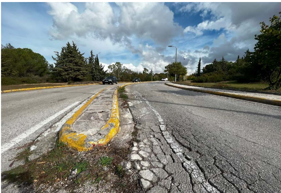
Φωτογραφία 3. Αλιγατορικές ρηγματώσεις
